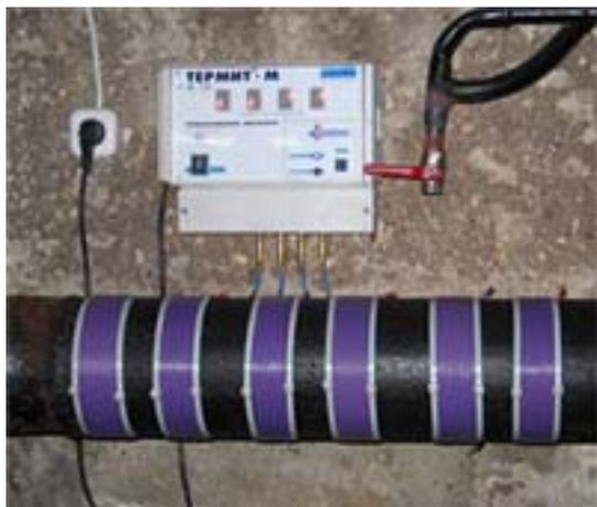
Электронный преобразователь солей жесткости воды «ТЕРМИТ» относится к последнему поколению устройств безреагентной обработки воды, широко распространенных за рубежом, и представляет собой наиболее эффективное и современное решение проблемы накипи и энергосбережения в теплообменном оборудовании.
